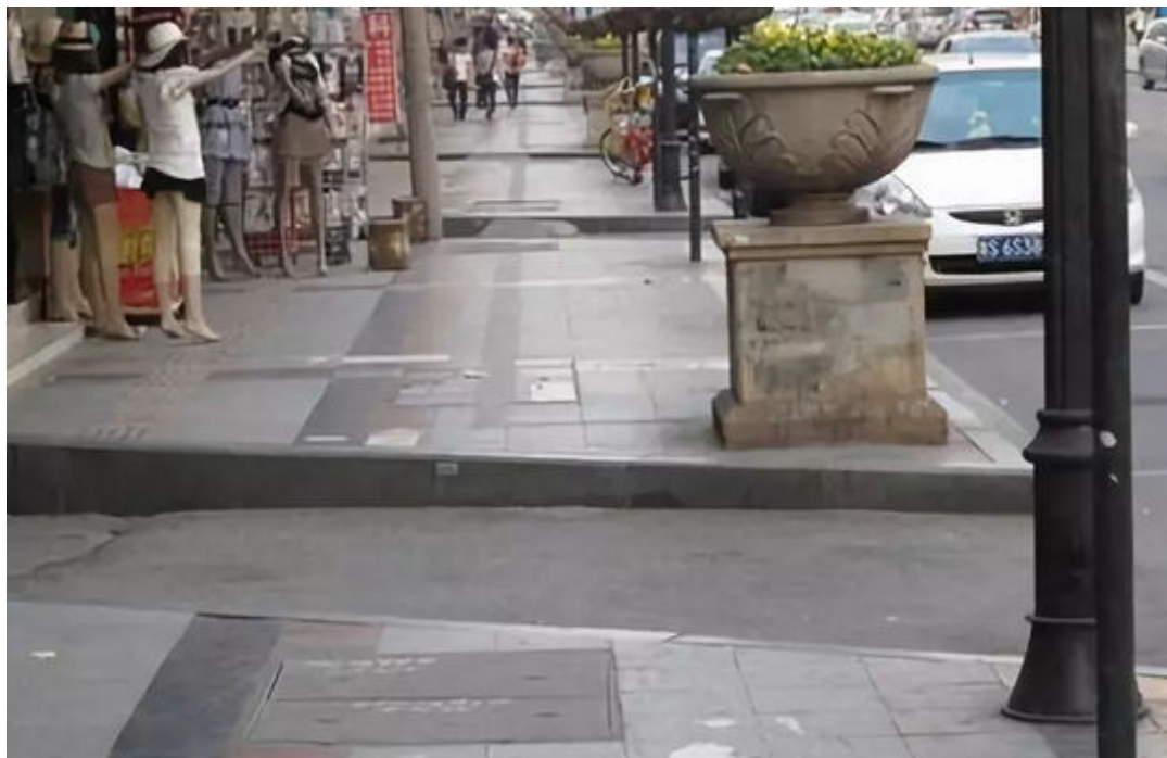
(路缘石无设置坡度、机动车出入口随意切割人行道导致不连续)
